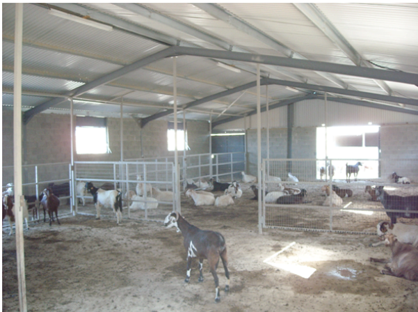
Υποστατικό αιγοπροβάτων με μεταλλικές διατομές και πάνελ πολυουρεθάνης
